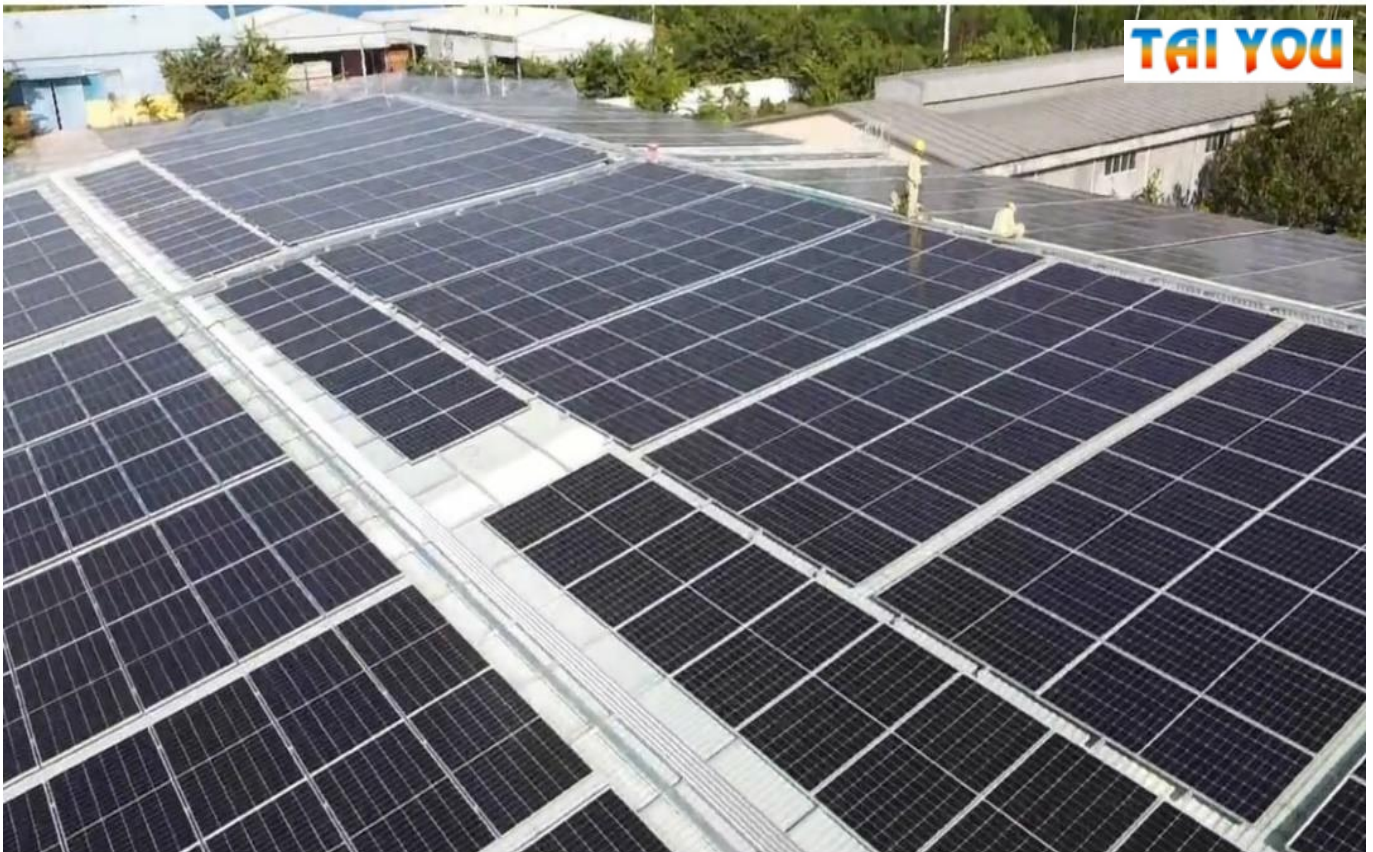
Hình ảnh thi công tại Công trình Moonsea- Glass
