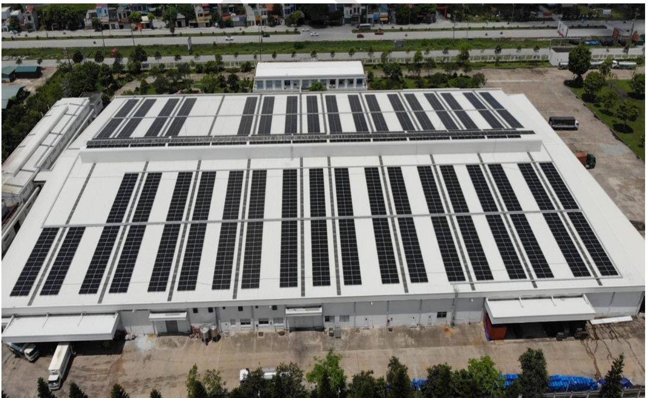
Hình ảnh thi công tại Công trình Vinamilk Lam Sơn, KCN Lễ Môn
