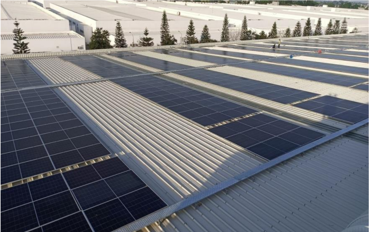
Hình ảnh thi công tại Công trình Vinamilk Tiên Sơn 1, Kcn Tiên Sơn
