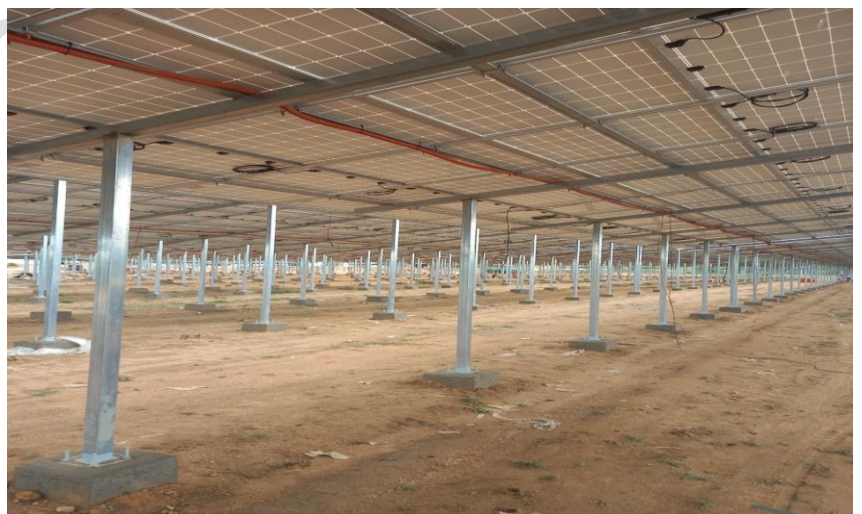
Hình ảnh thi công tại Trang trại Nấm Đức Sang Gia Lai
