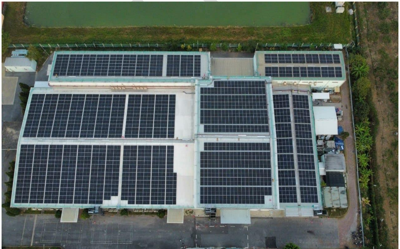
Hình ảnh thi công tại Công trình NM TOA, KCN Bắc Thăng Long
