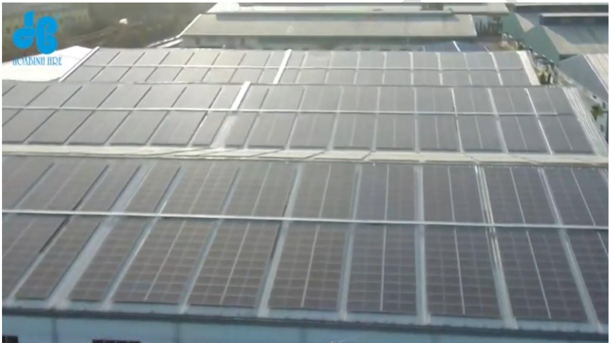
Hình ảnh thi công tại Nhà xưởng HUADA FURNITURE Việt Nam
