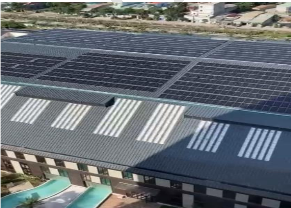
Hình ảnh thi công tại KDL Mikazuki Japanese Đà Nẵng
