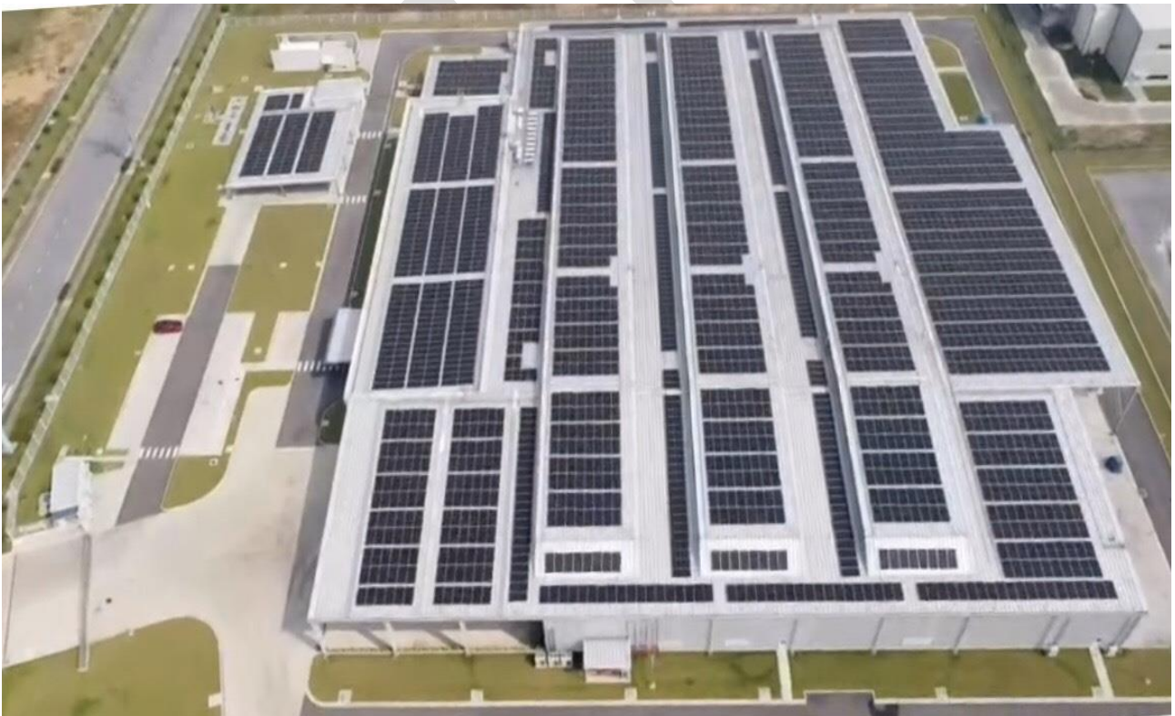
Hình ảnh thi công tại Công trình NM SUMIRIKO, KCN Thăng Long 3
